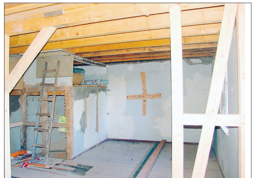
Im Innern der Bakuninhütte hat sich schon eine Menge getan. Das linke Bild zeigt den unteren Raum, der Wanderern auch in Zukunft Schutz bieten soll. Rechts ein Blick ins Obergeschoss. Dort wurden bereits viele verfaulte Balken ausgetauscht.
