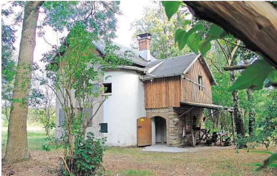
Die Bakuninhütte auf der Hohen Maas steht nun unter Denkmalschutz.
